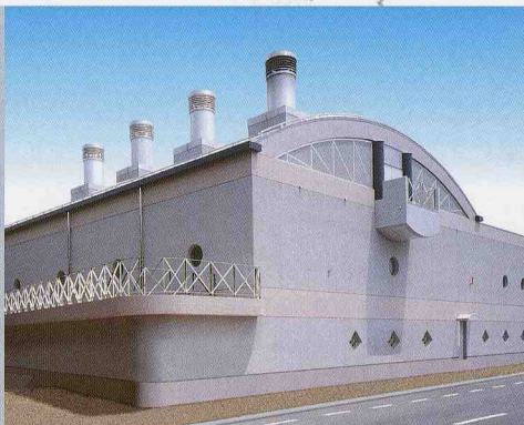
高知市薊野ポンプ場殿 (1996年納入)
