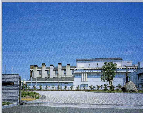
高知市 海老の丸ポンプ場殿 (1999年納入)
