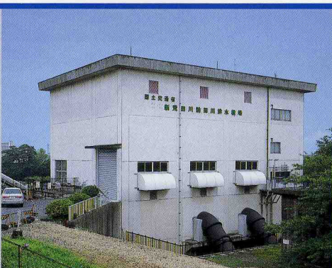
岐阜県内排水機場殿 (2001年納入)
