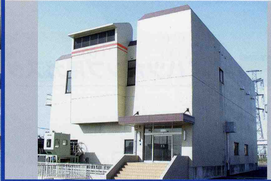
千葉市 生実川排水機場殿 (1999年納入)
