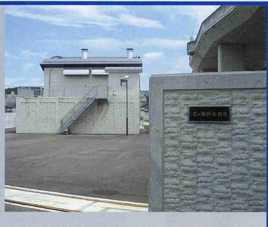
大分県内排水機場殿 (2001年納入)
